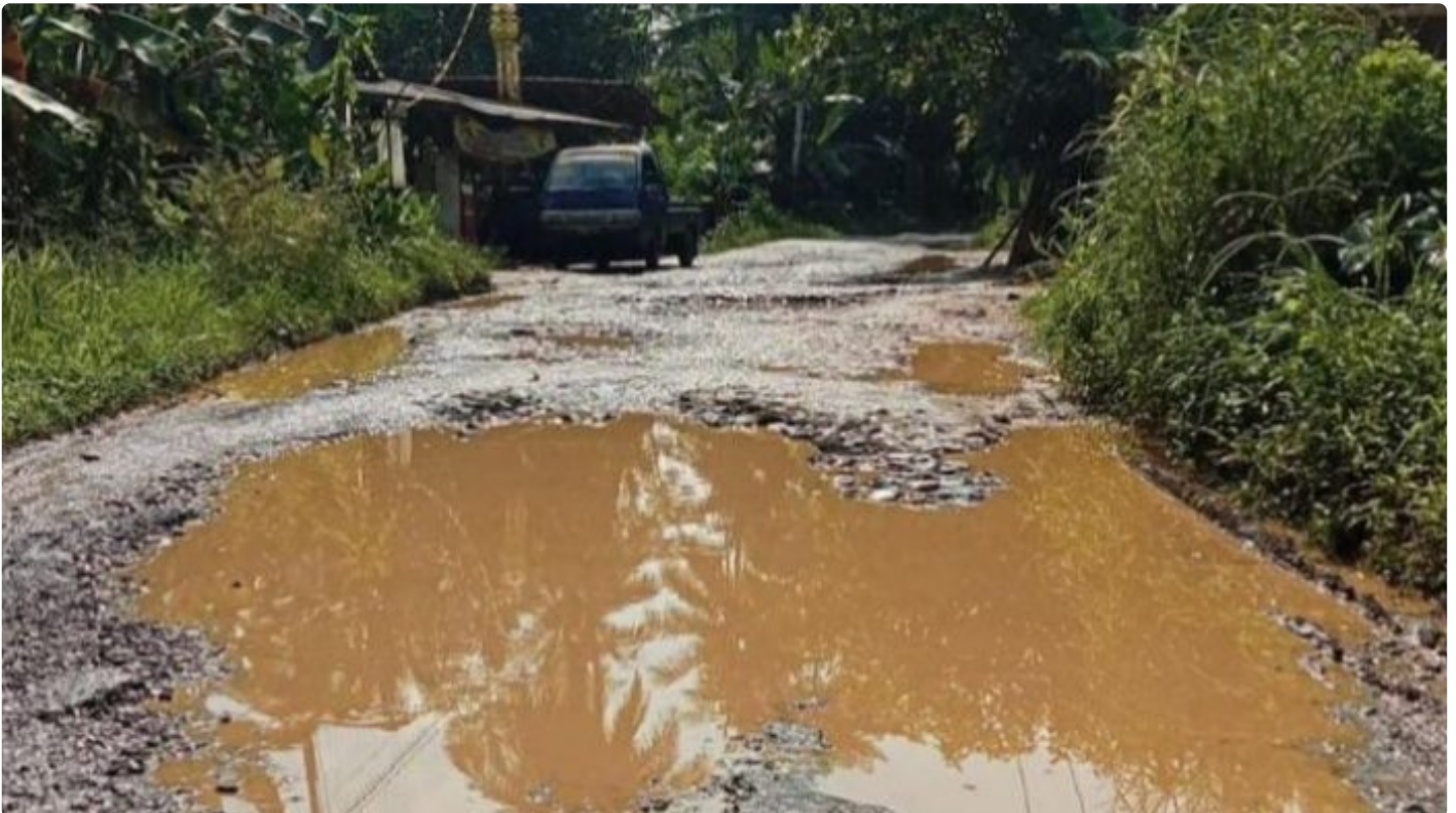
Jalan Jembatan Kayu - Wanasalam rusak parah dan lama dibiarkan
